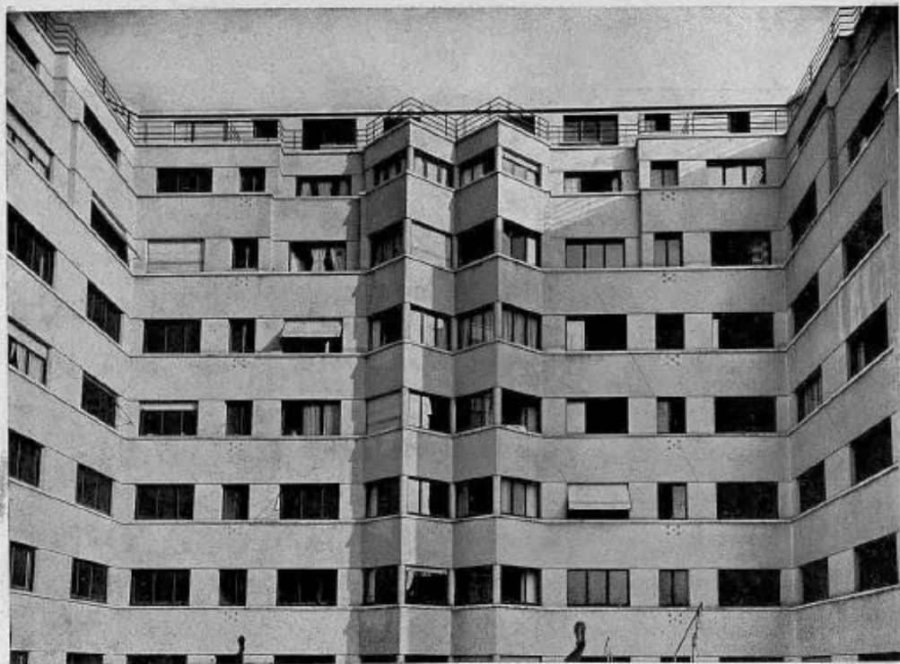
FAÇADE SUR MITOYEN. ARCHITECTES: HENNEQUET FRÈRES Revêtement en Comblanchies clair, menuiserie métallique peinte en vert foncé.
